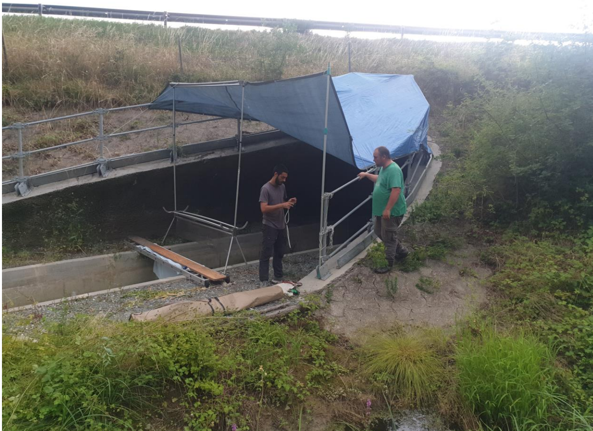
Installation du dispositif en cours avec Harp-Trap, pont et écran visuel.
